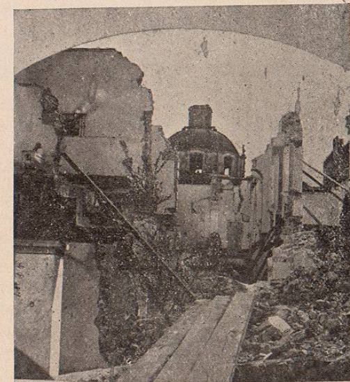
TEMPLO Y CONVENTO DE CAPUCHINAS. DEMOLICION.—APERTURA DE LA CALLE DE LERDO.
