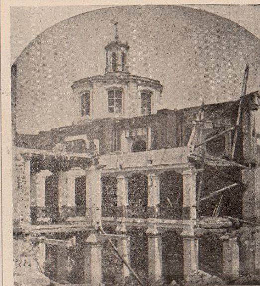
CONVENTO DE S. BERNARDO.—DEMOLICION.
