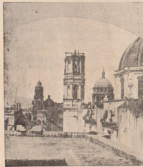
SANTA INES.—DEMOLICION DE LA TORRE.
