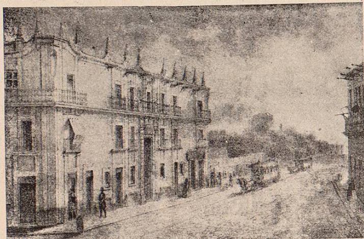
HOSPITAL DE TERCEROS.
