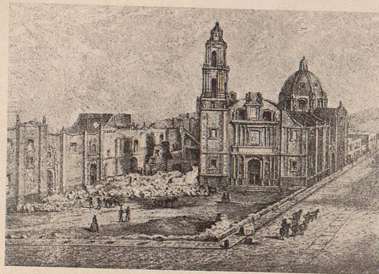
CONVENTO DE SANTO DOMINGO EN DEMOLICION.
