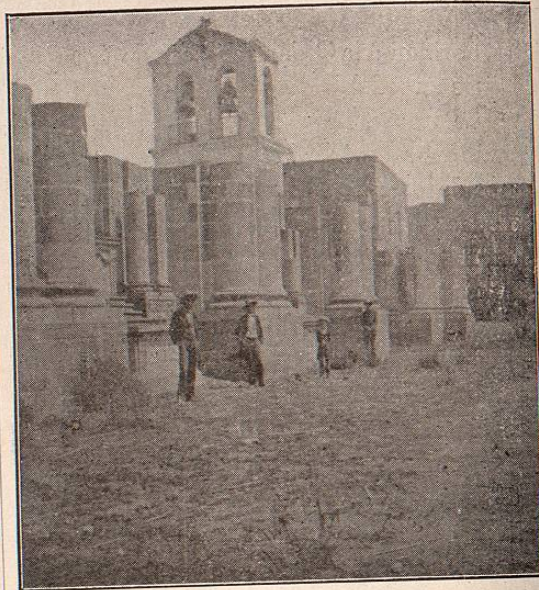
NUEVO TEMPLO EN CONSTRUCCION.
