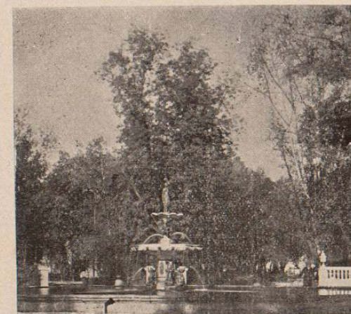
GLORIETA CENTRAL DE LA ALAMEDA (ESTADO ACTUAL).
