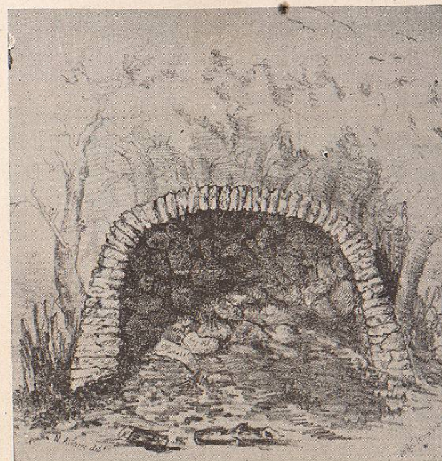
RUINAS DE METLATUYUCA. BÓVEDA.
