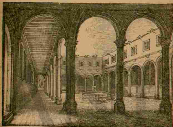
Lámina 18ª. — Convento de dominicos. — Los frailes dominicos fueron colosísimos defensores de los indios, ellos fueron los que con más valentía defendieron la libertad de los conquistados ante los reyes. Después quedaron encargados de la Inquisición y adquirieron inmensas riquezas.
