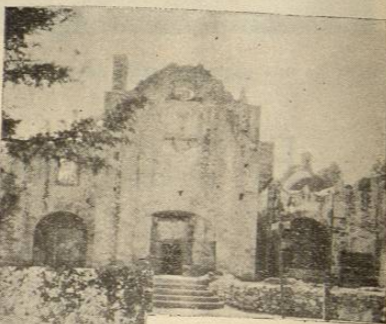
Fachada principal de la Iglesia.
