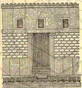
EXTÉRIEUR D'UNE MAISON ROMAINE.
