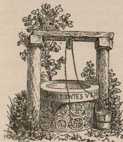
Puits de Saint-Jean-Porte-Latine
