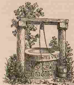
Puits de Saint-Jean-Porte-Latine
