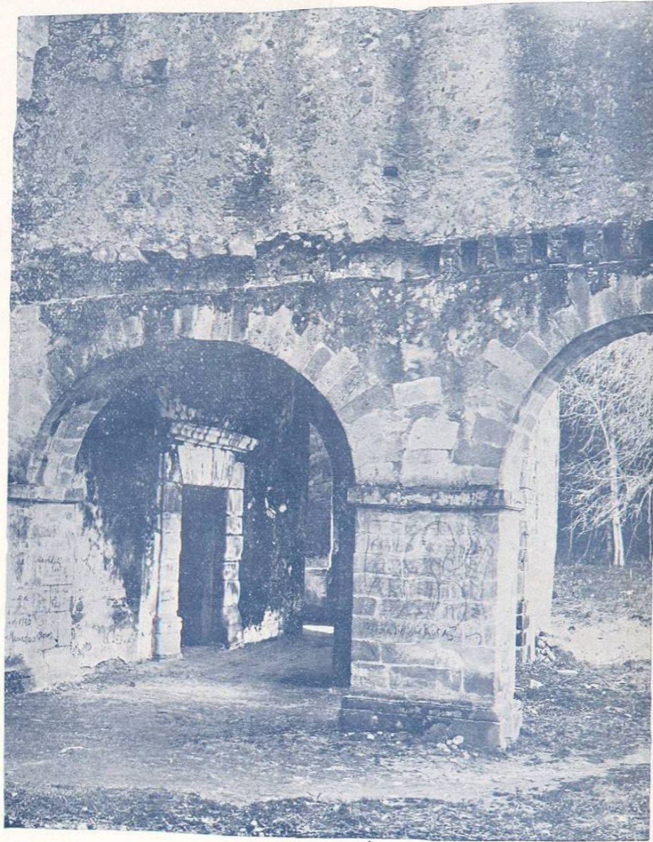
VISTA LATERAL DE LA ENTRADA A LA CAPILLA
