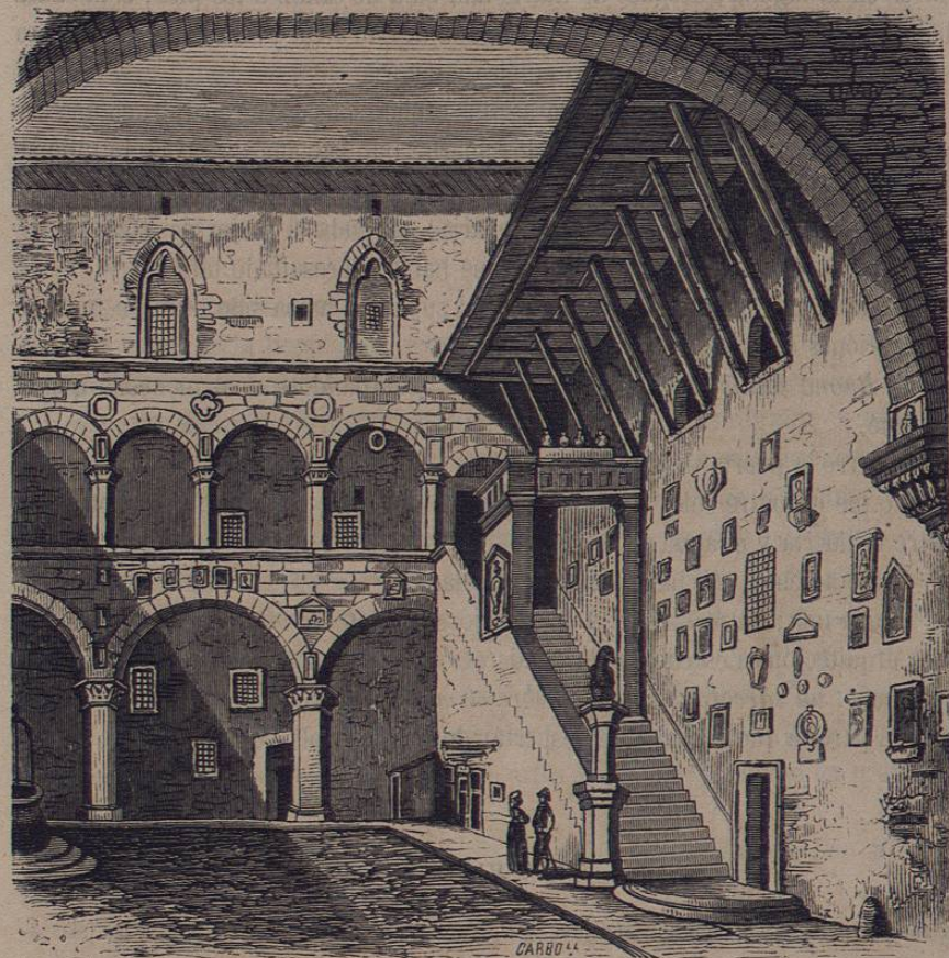
Palacio del Podestà, en Florencia.
