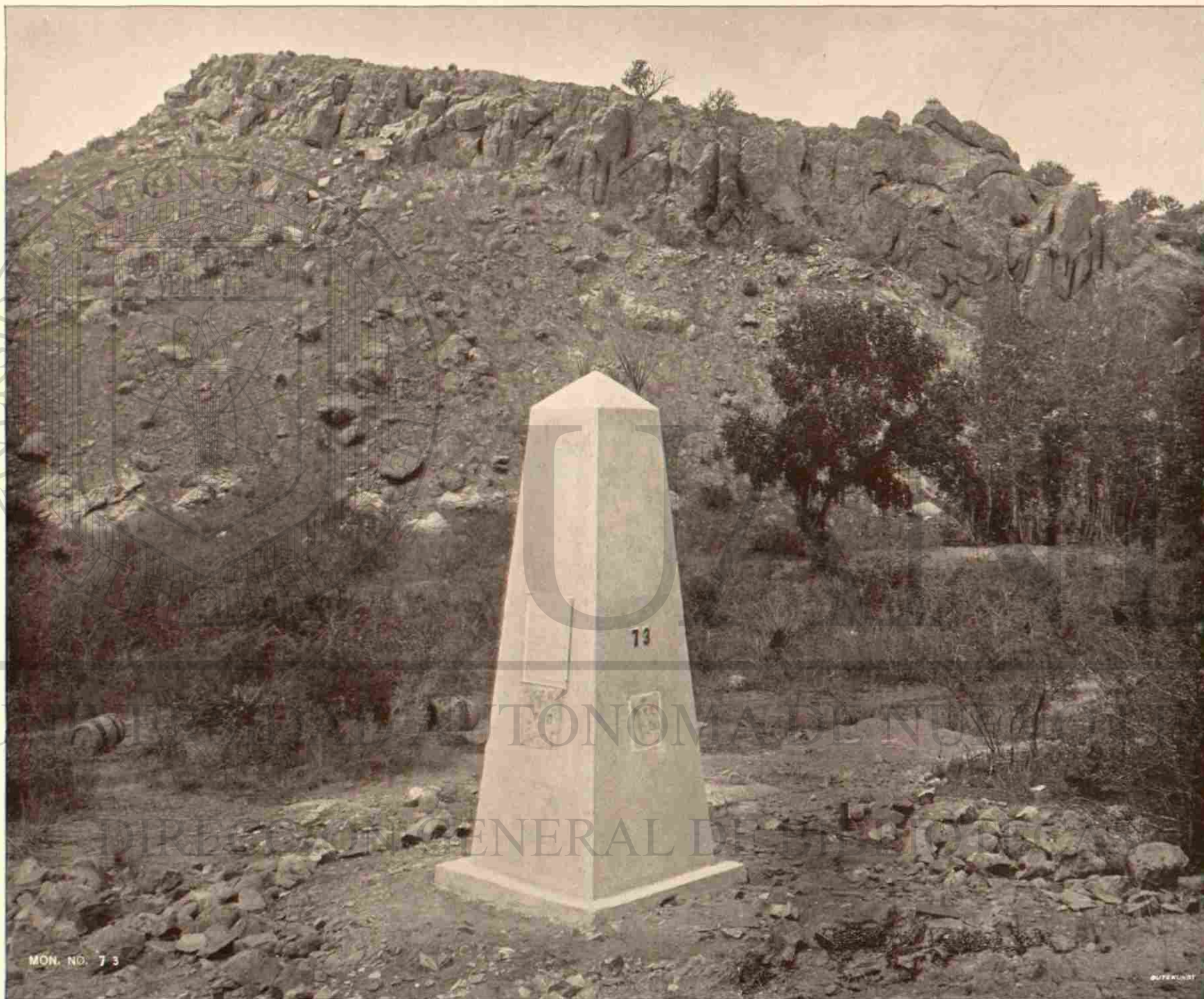
MONUMENTO NÚMERO 73 (MAMPOSTERÍA), VISTA AL NOROESTE.—EN EL CAÑÓN DE GUADALUPE.
