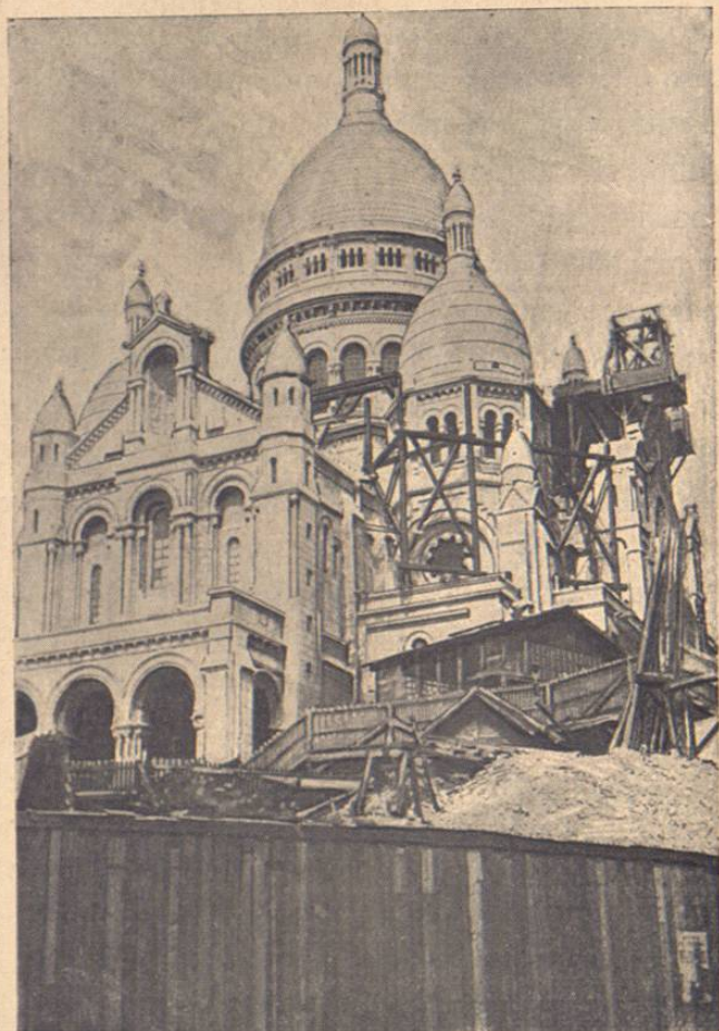
BASÍLICA DEL SAGRADO CORAZÓN DE JESÚS EN MONTMARTRE (PARIS). ESTADO ACTUAL DE LAS OBRAS. 1901.
