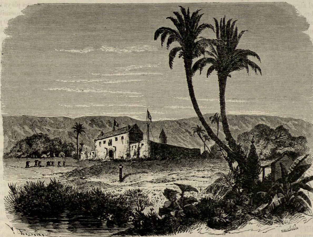
Vista del fuerte francés de Widah.
