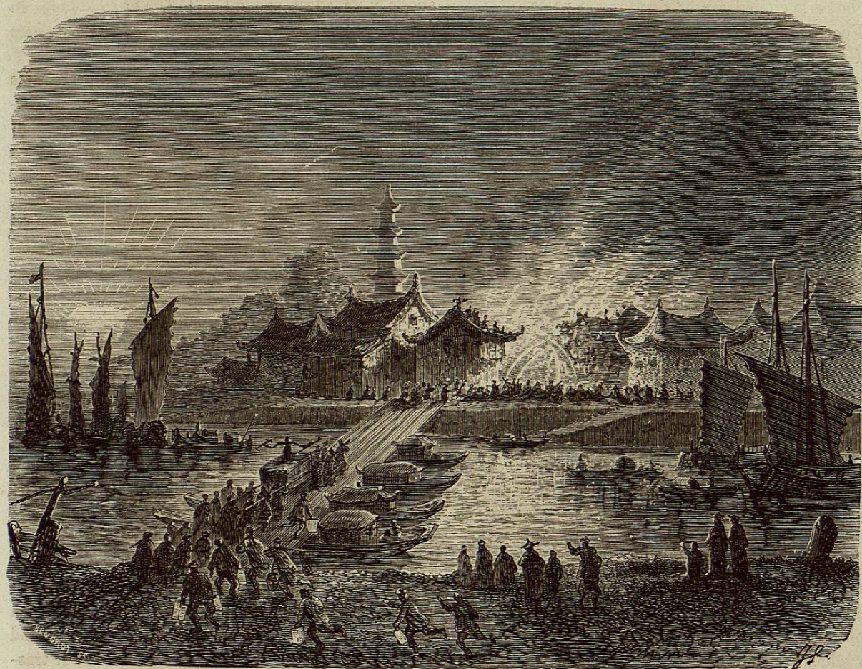
Escena de incendio en China.
