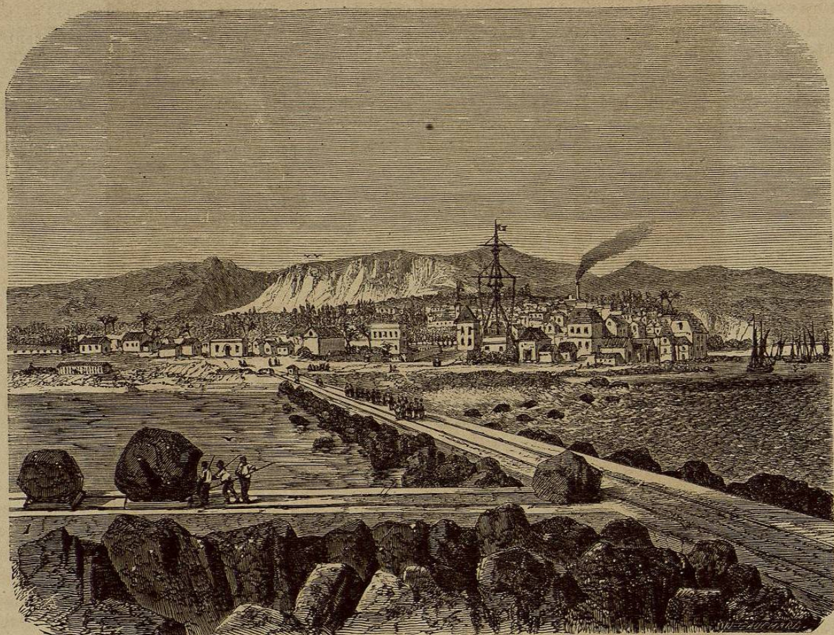
Obras del puerto de san Pedro.
