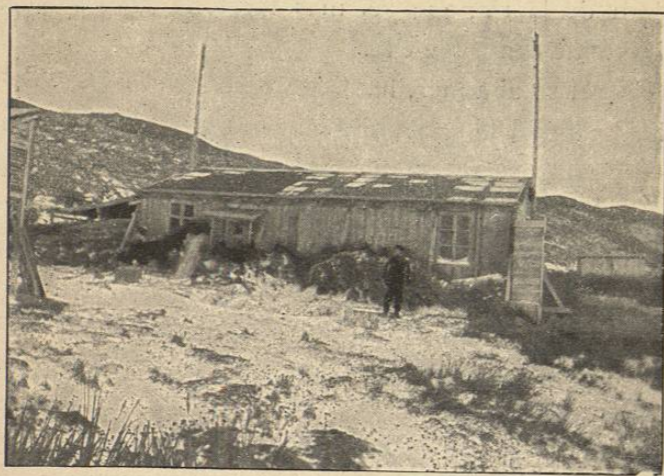
Casa-vivienda de la estación alemana.—Bahía Real.
