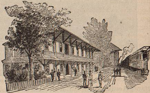
ESTACION DEL INDIO—Arizona.
