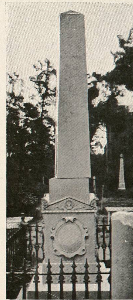
EFFET D'UNE SECOUSSE SISMIQUE EN 1886 SUR UNE COLONNE AUX ÉTATS-UNIS
