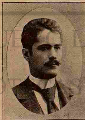
D. Leandro Iraguirre, que trabajó en el cuadro, “El Primer Milagro de la Santísima Virgen de Guadalupe,” Obra de Carrasco.
