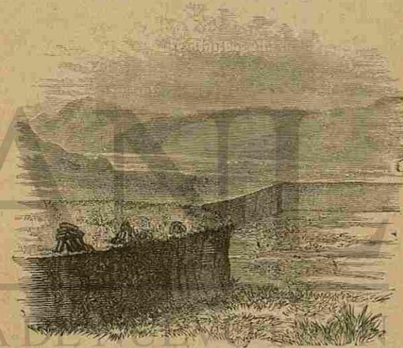
Fig. 20. — Sección de un turbal ó turbera, donde se corta la turba y se forman montoncillos de ella para secarla y que sirva de combustible.
