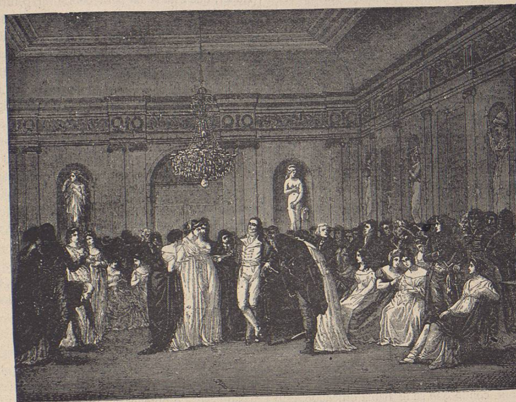
Recepción en casa de Barras
