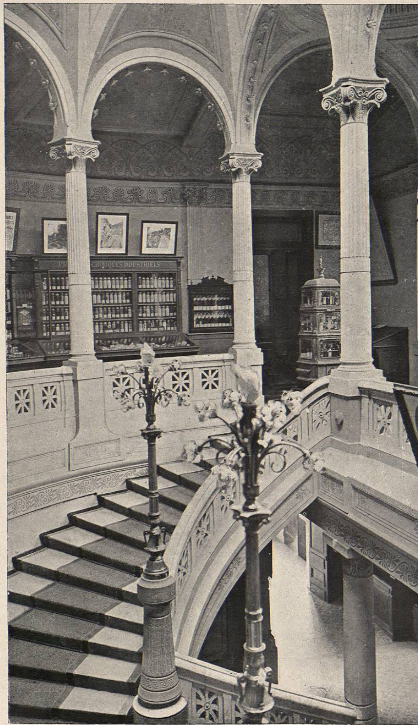
PARTE ALTA DE LA ESCALERA
