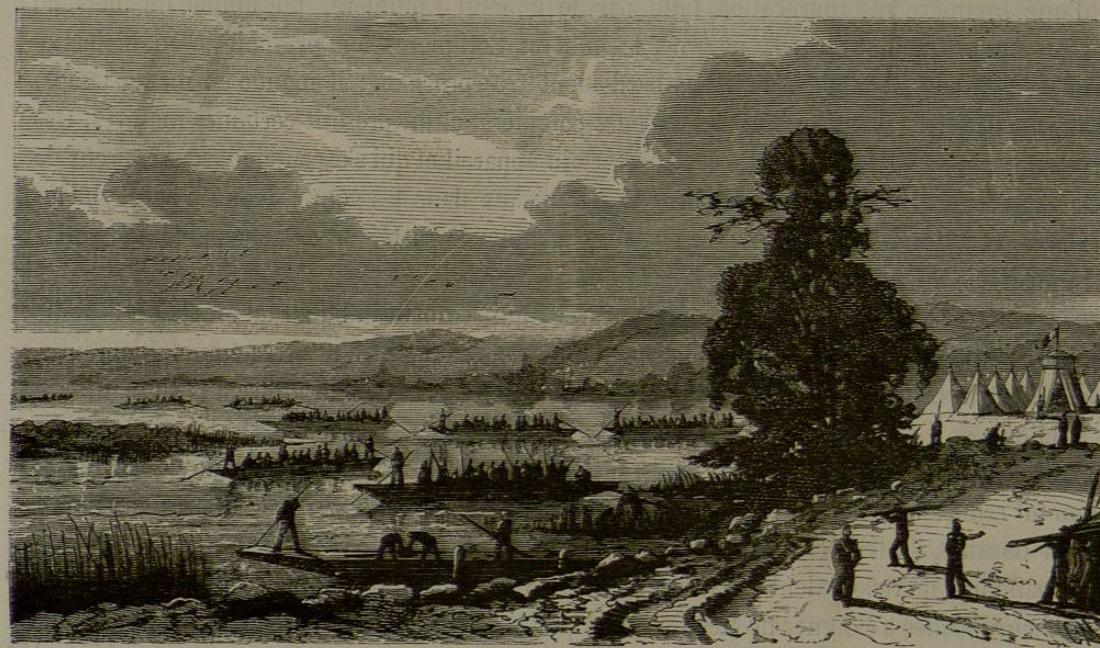
ESSAI DE PONTS DE BATEAUX SUR LA MOSELLE.
