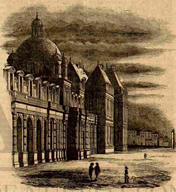
PALACIO DE LAS TULLERIAS.
