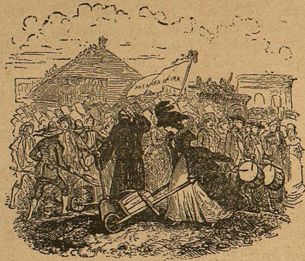
Los trabajos en el Campo de Marte
