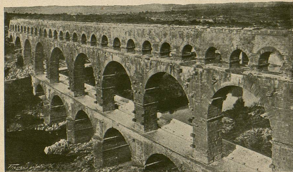
Acueducto de Gard, situado á 27 kilómetros de Nimes
