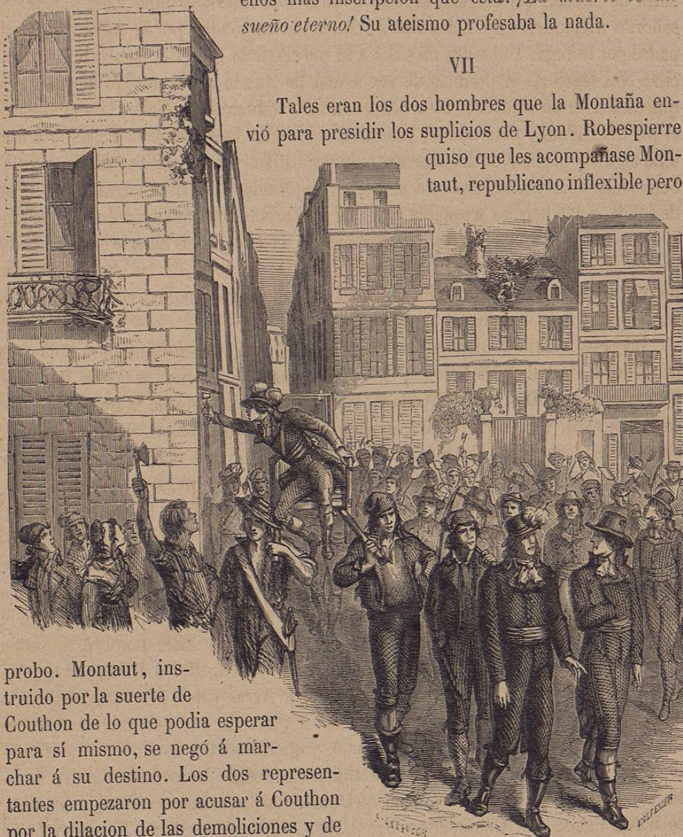
Demolicion de edificios en Lyon.—Pág. 218.
