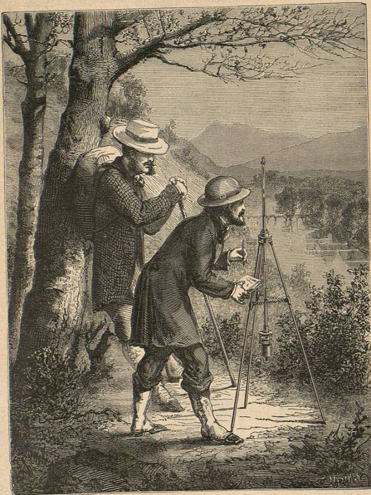
Fig. 73.—Instalación del barómetro de Fortín
