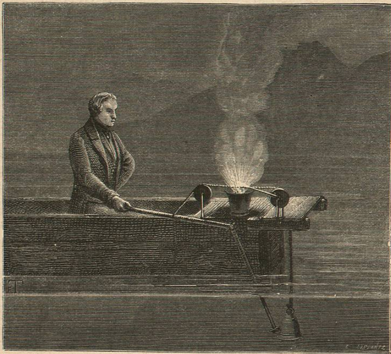
Fig. 251.—Medida de la velocidad del sonido en el agua. Estación de partida
