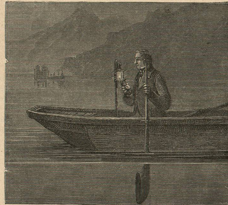
Fig. 252.—Medida de la velocidad del sonido en el agua. Estación de llegada
