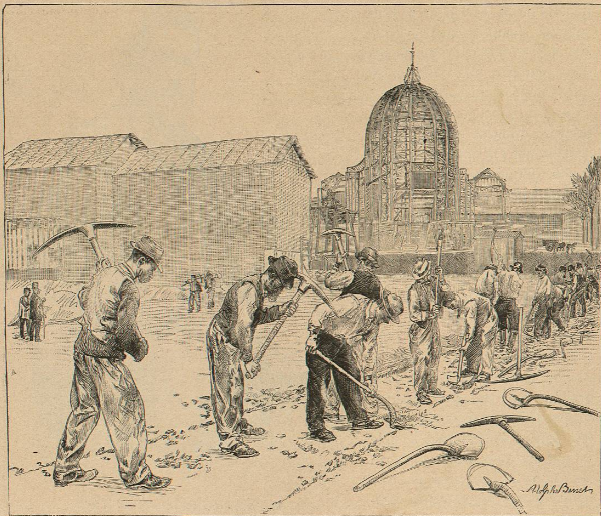
Apertura de zanjas para los conductos de agua y de gas
