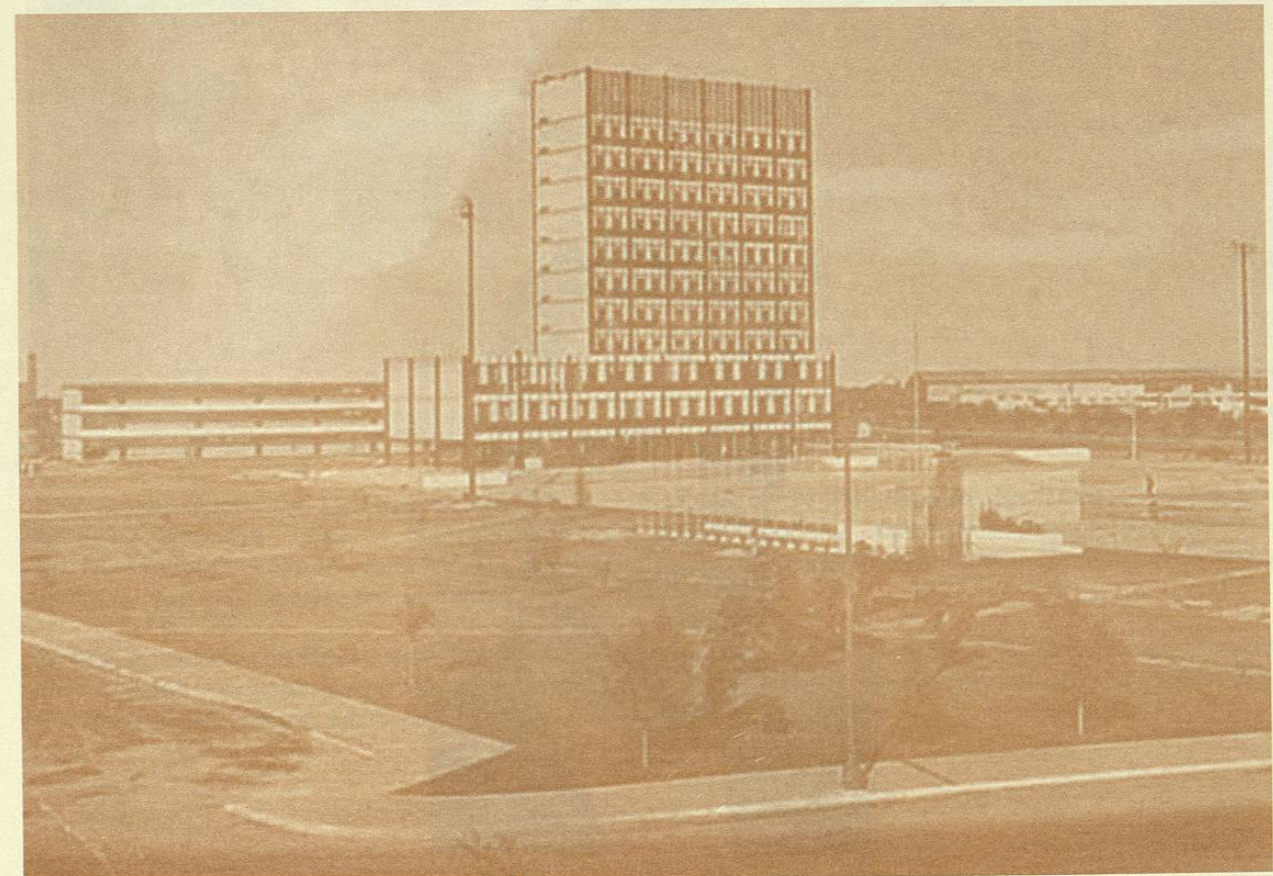
Edificio/ Rectoría y FDYC 1962.
