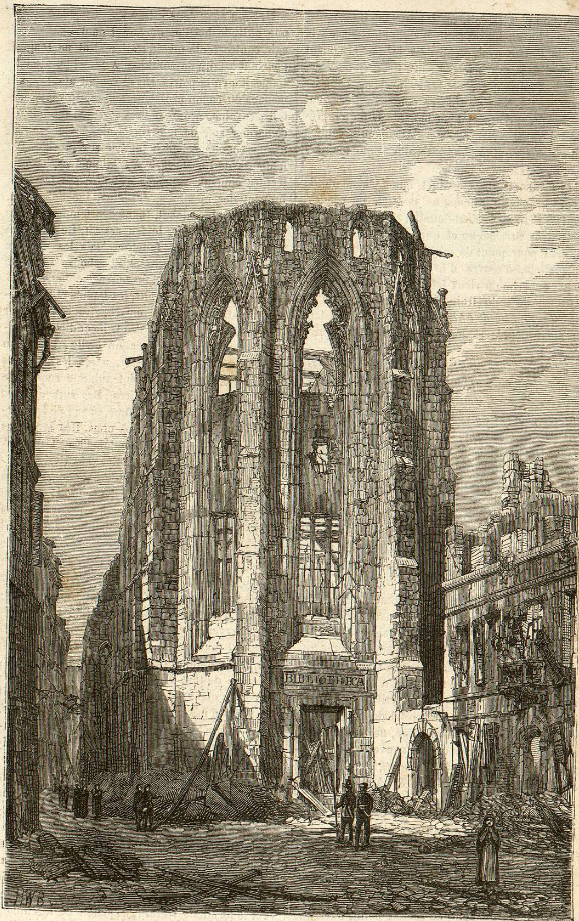
SIÈGE DE STRASBOURG. — Ruines de la Bibliothèque après le bombardement.
