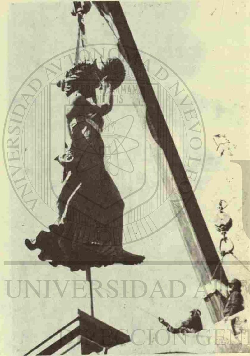
Por medio de bandas integradas al extremo de una grúa, es retirada la estatua de la clave del arco el 11 de enero de 1997.
