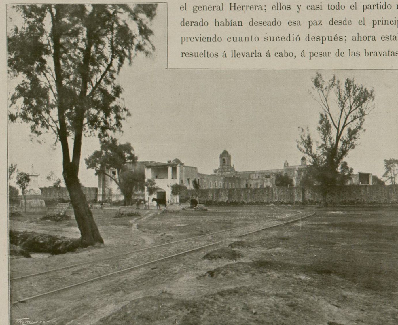
Convento de Churubusco (estado actual)
