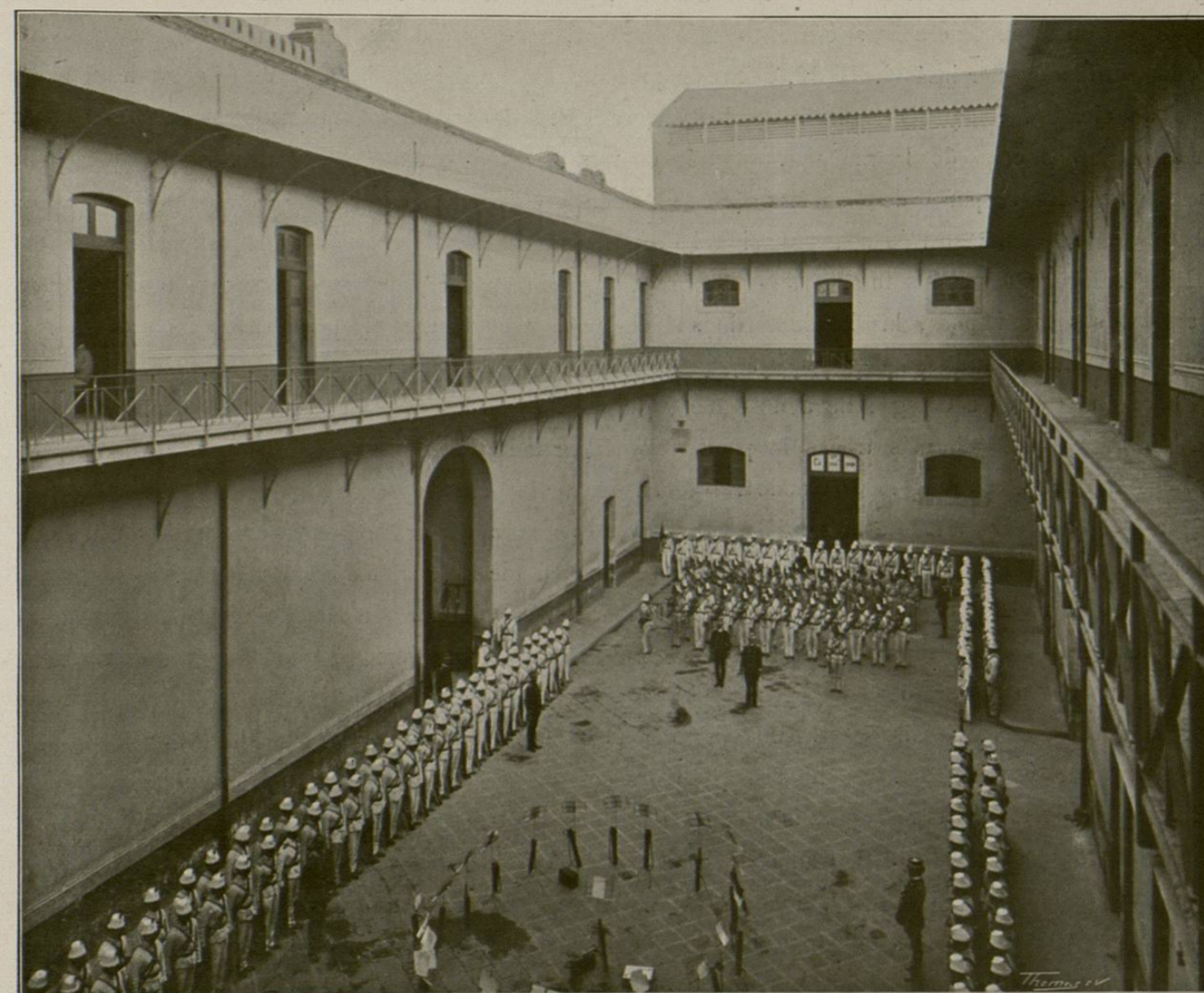
Edificios modernos. — Patio del 7.º regimiento
