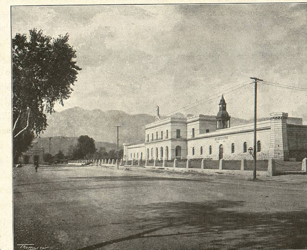
Estado de Nuevo León.— Penitenciaría de Monterrey
