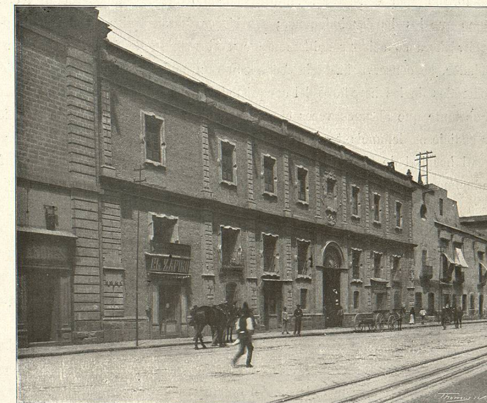
México.—Fachada del hospital de San Andrés
