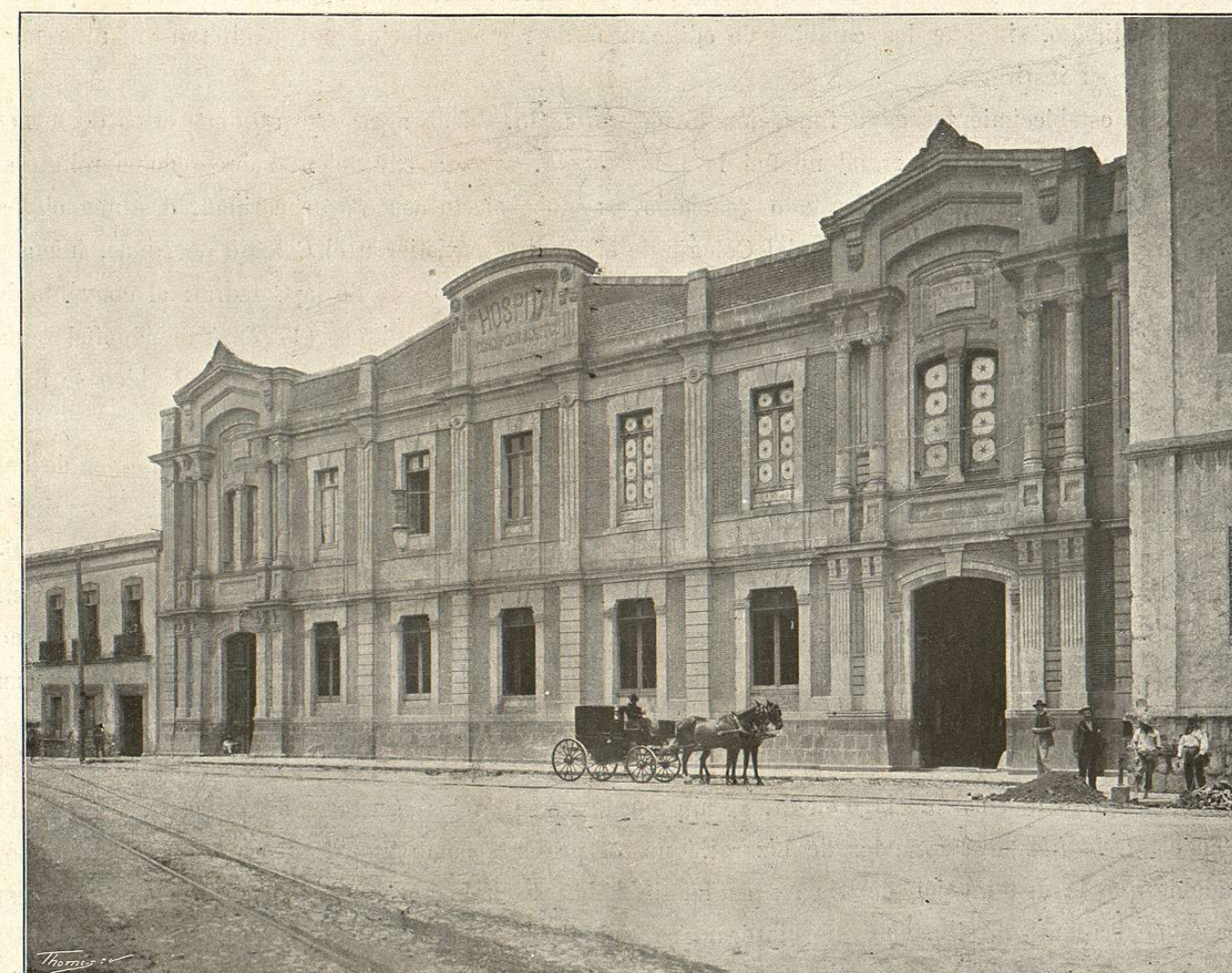
México. — Fachada del hospital «Béistegui.»
