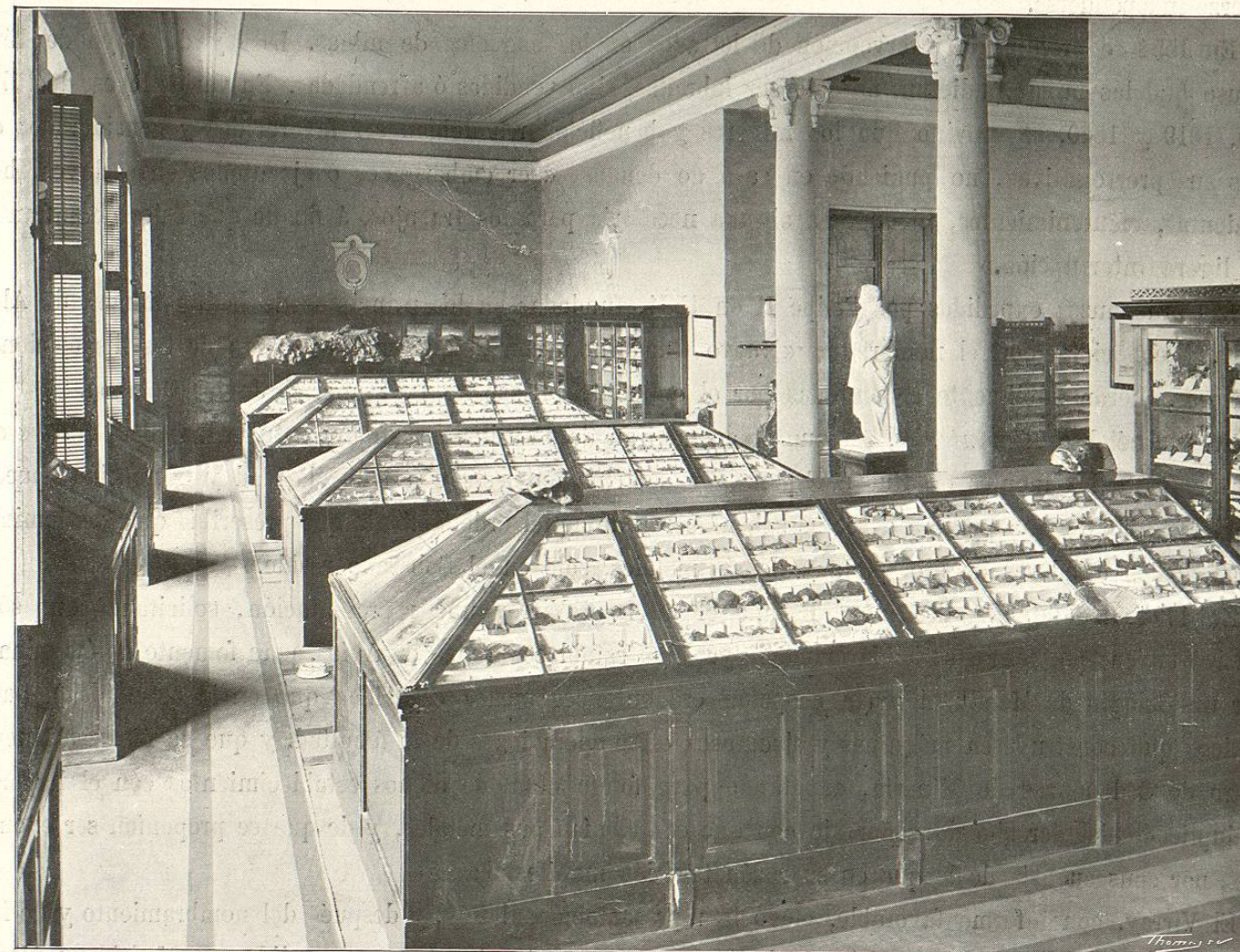
México.—Escuela de Minería. Sala de Mineralogía
