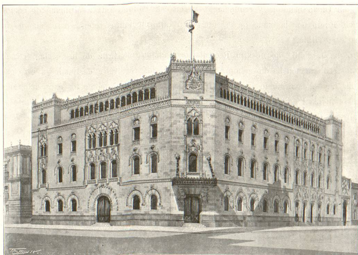
México. — Nuevo edificio de Correos, en construcción
