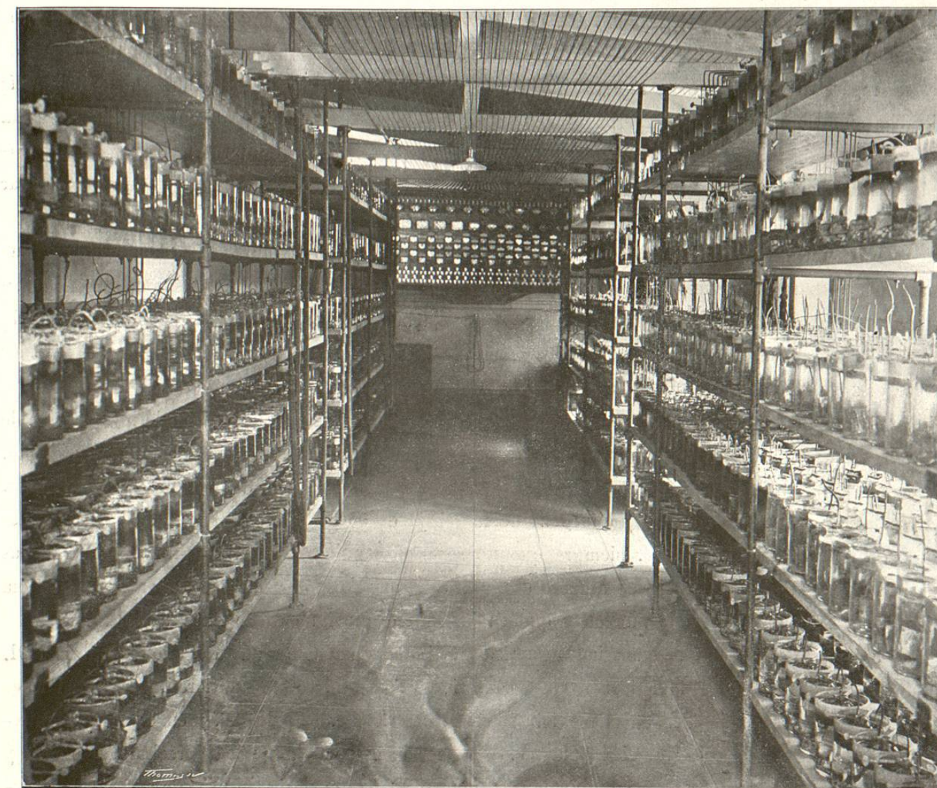
México. — Telégrafos federales. Sala de pilas
