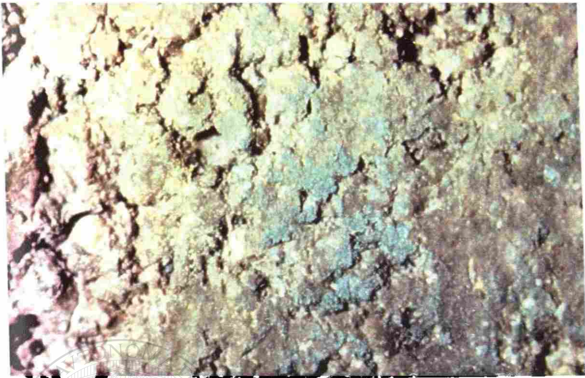
Fotografía 49 Capa en ladrillo sin tratamiento.
