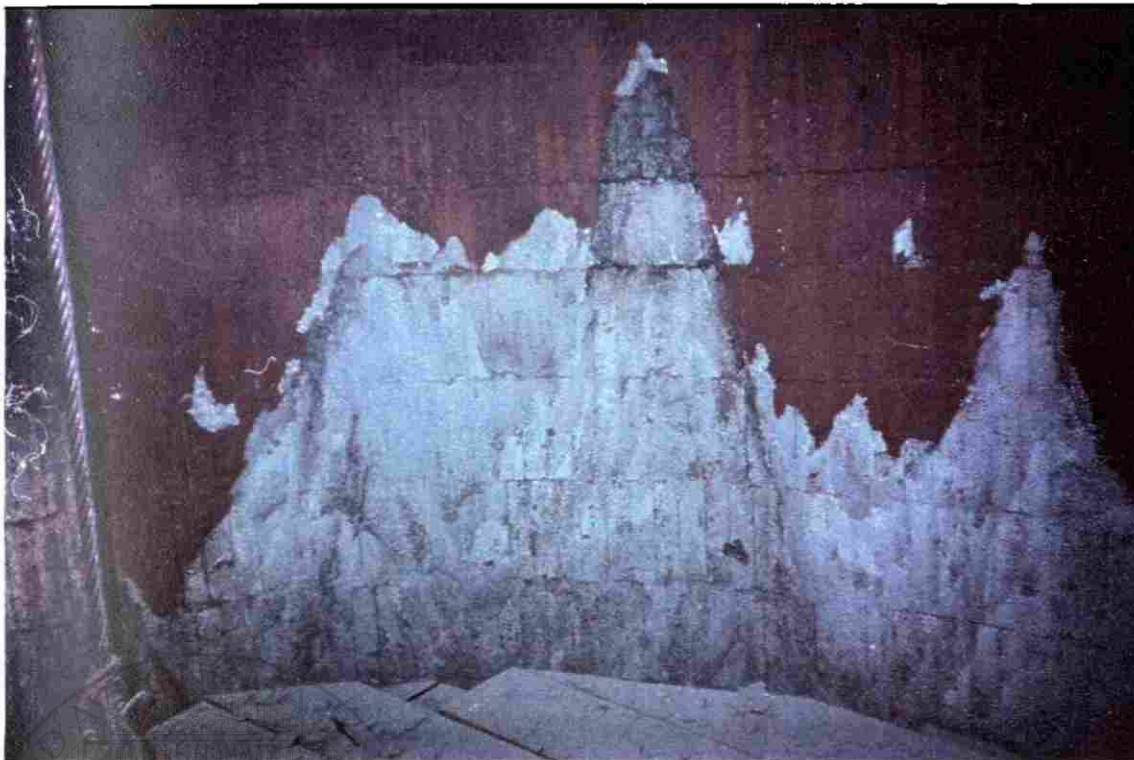
Fotografía 3. Marcas dejadas por las capas al desprenderse del reactor.
