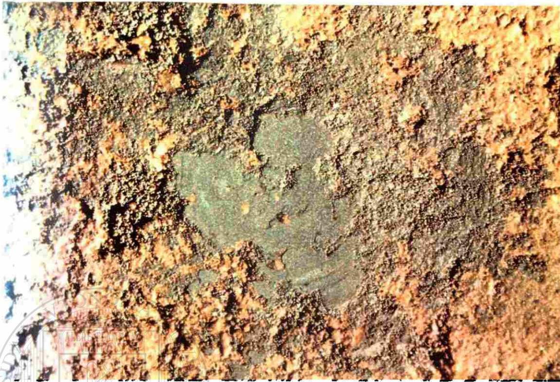
Fotografía 37 Muestra de ladrillo con capa
