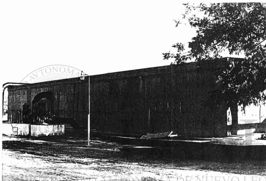
DIRECCIÓN GENERAL DE BIBLIOTECAS Figura 6 Nuevo Tanque de Almacenamiento
