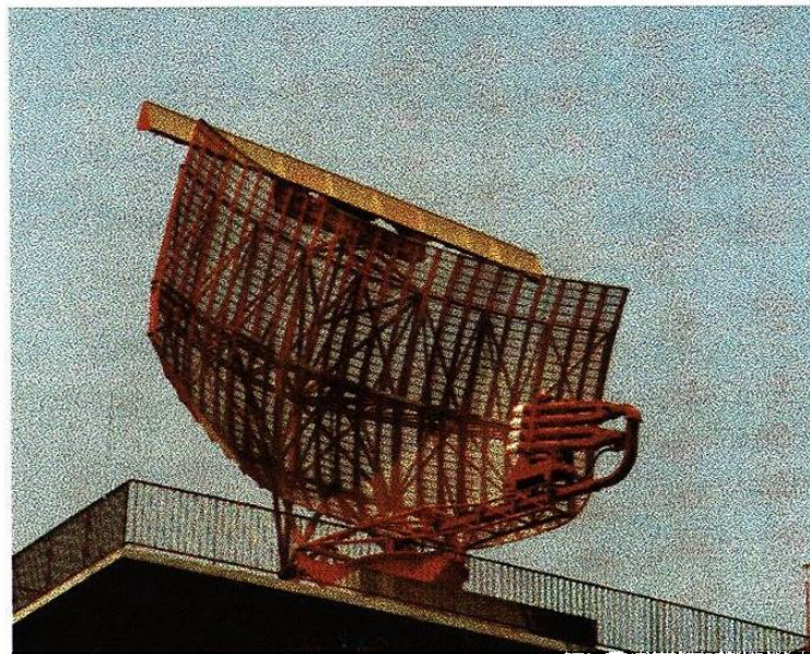
Fig. 3.9 Radar de ruta primario
