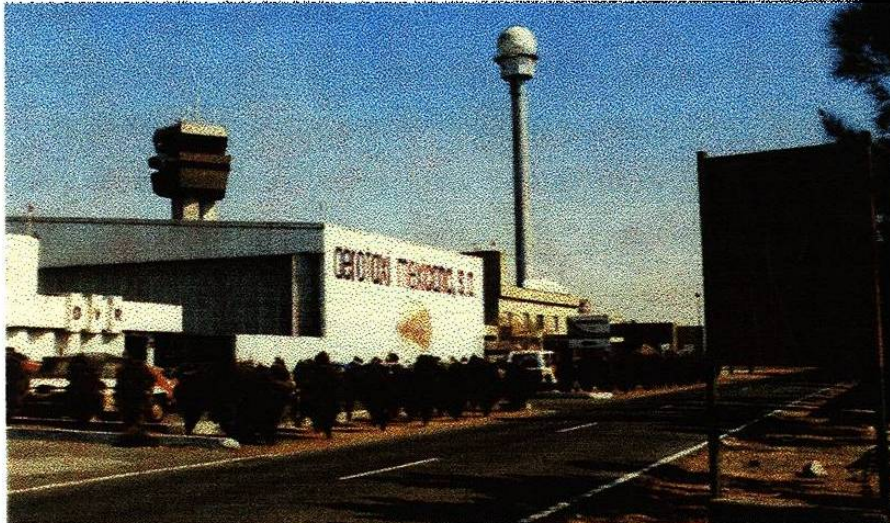
Figura 3.3 Torre para Radar de Superficie
