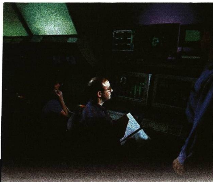
Fig. 11.2 Centro de control
