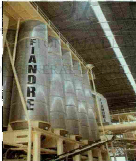
Figura 9. Silos de almacenamiento.
