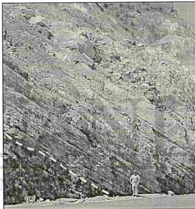
Fig. 2.16 Formación Otates. Nótese el contraste litológico entre la Formación Tamaulipas Inferior subyacente. La línea punteada marca el contacto litológico. Km. 29+450. Vista hacia el SW.
