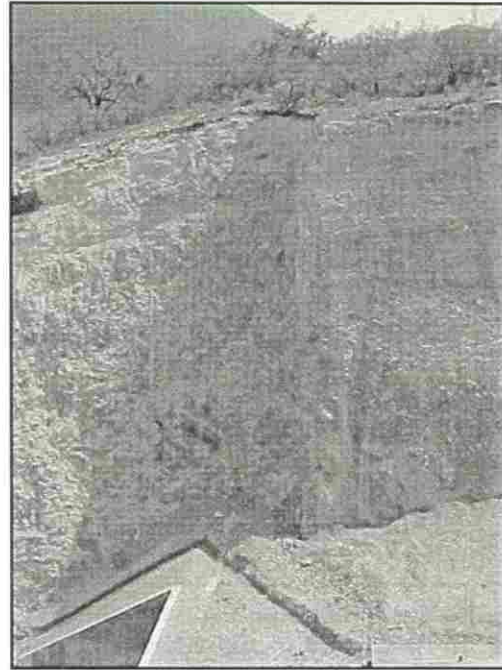
Fig. 2.23 Coluvión ubicado en la parte superior del túnel falso.
